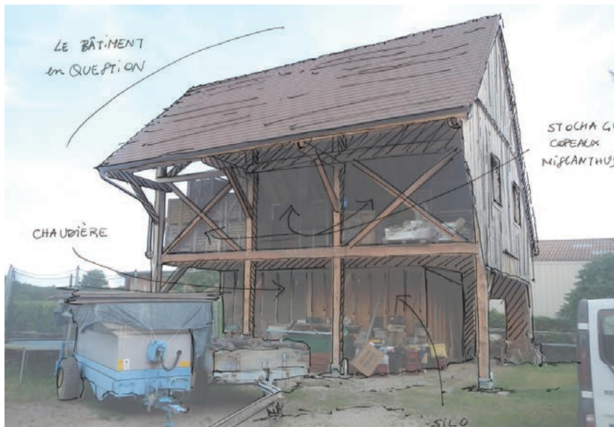
Le nouveau bâtiment abritant la chaudière et un espace de stockage à l'étage
