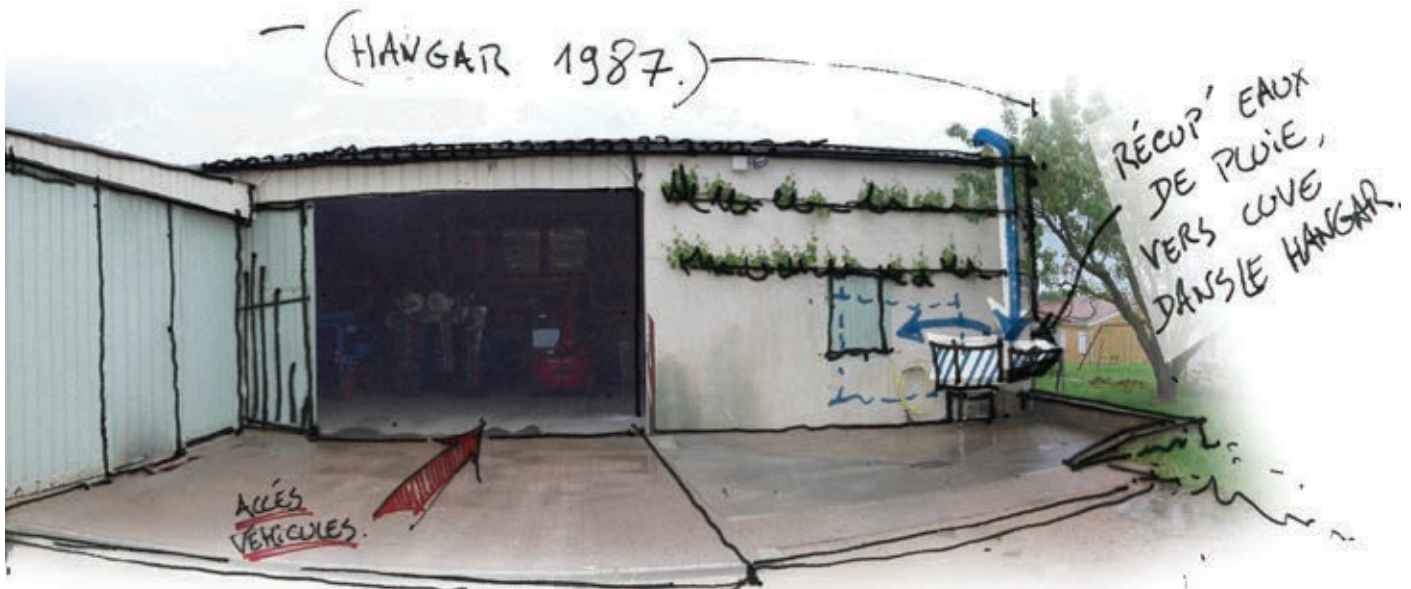
Vue générale du système de filtration accolé au hangar (les cuves de stockage sont à l'intérieur)
